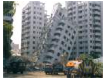
Іл. 40.15. Наслідки землетрусу
