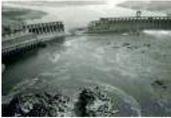
Іл. 42.8. Зруйнована вибухом гребля Дніпрогесу в 1941 р.
