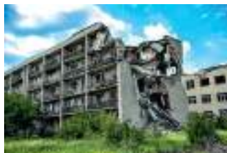
Іл. 44.11. Руйнування будівлі внаслідок обстрілу
